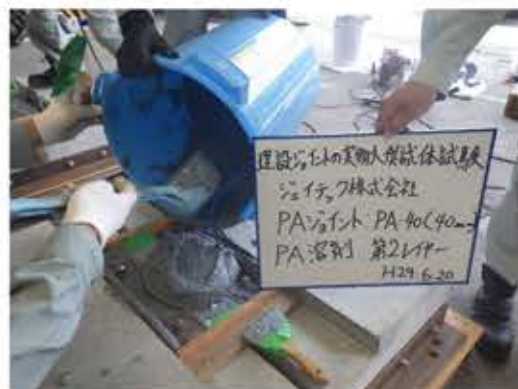
PA溶剤、第2レイヤー流込み
