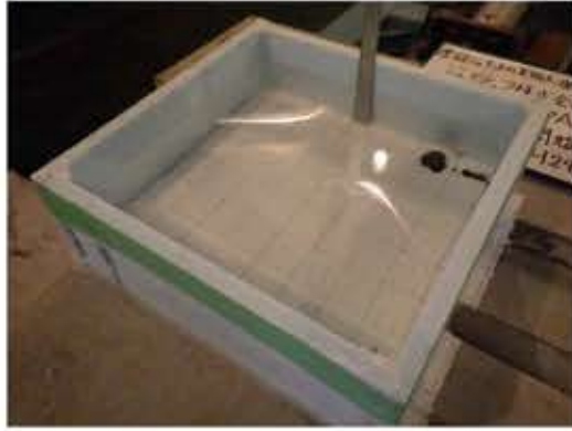
水張り試験状況
