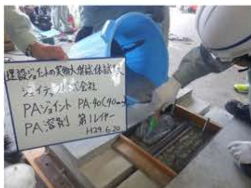
PA溶剤、第1レイヤー流込み
