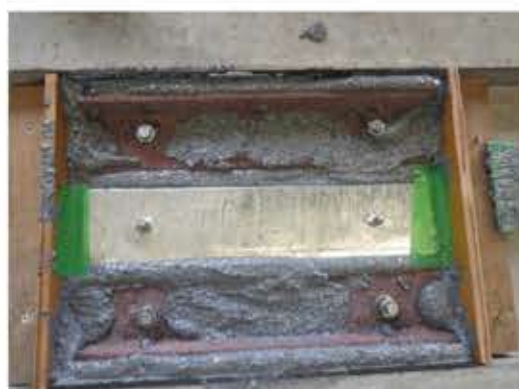
プレート設置
