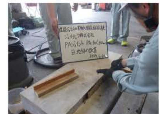
目地材の設置
