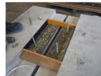
コンブリテープ貼付
