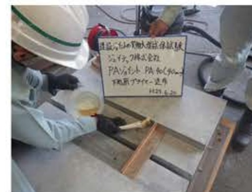
下地用プライマー塗布
