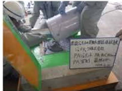
PA溶剤、最終レイヤー流込み
