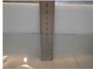
（漏水なし） 水張り試験状況
