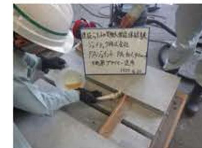
下地用プライマー塗布
