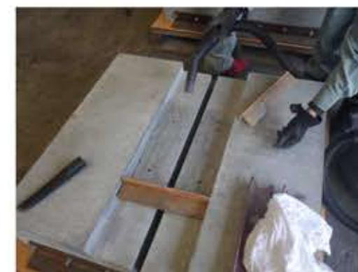
清掃および型枠の設置
