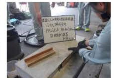
目地材の設置
