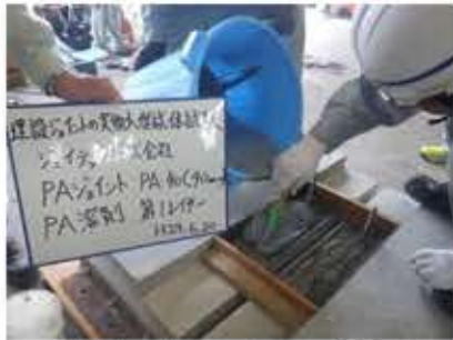
PA溶剤、第1レイヤー流込み
