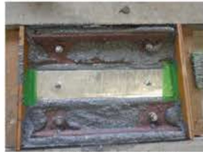
プレート設置、アングル固定
