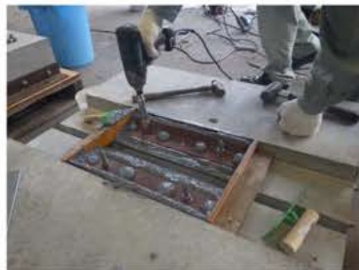
アングル設置、アングルの固定
