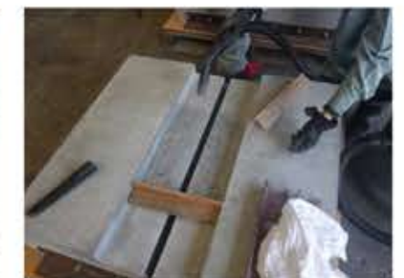
清掃、型枠の設置
