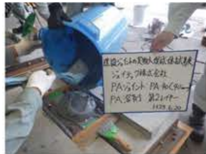
PA溶剤、第2レイヤー流込み
