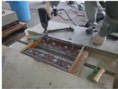
アングル設置、アンカー施工
