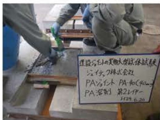
PA溶剤、第2レイヤー流込み
