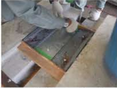
プレート設置、アングル固定
