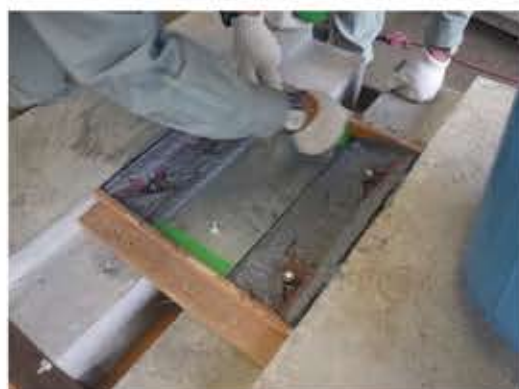
プレートの設置
