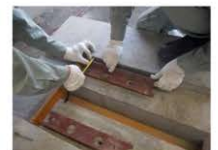
清掃、型枠の設置
