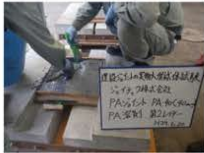
PA溶剤、第2レイヤー流込み
