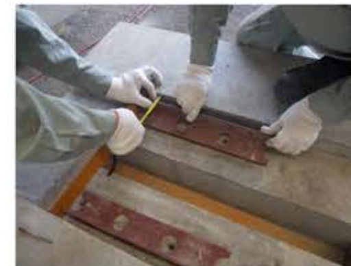
清掃および型枠の設置
