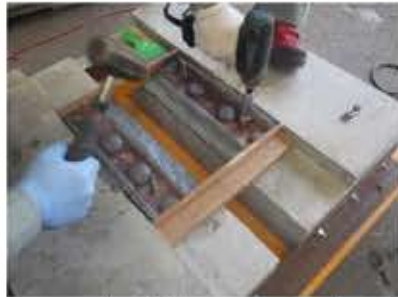
アングル設置、アンカー施工
