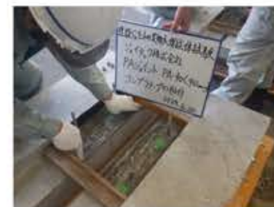
コンプリテープ貼付
