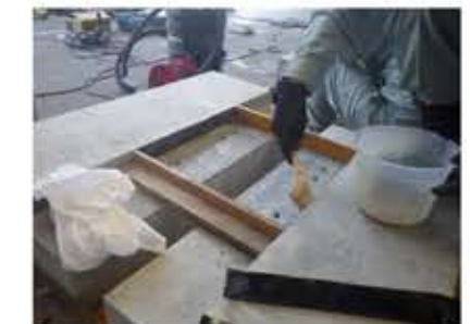
目地材の設置
