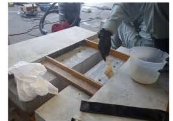
目地材の設置
