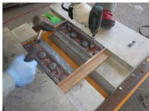
アングル設置、アングルの固定
