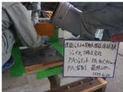
PA溶剤、最終レイヤー流込み
