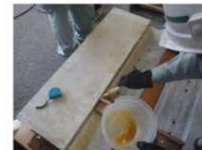
下地用プライマー塗布
