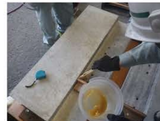
下地用プライマー塗布
